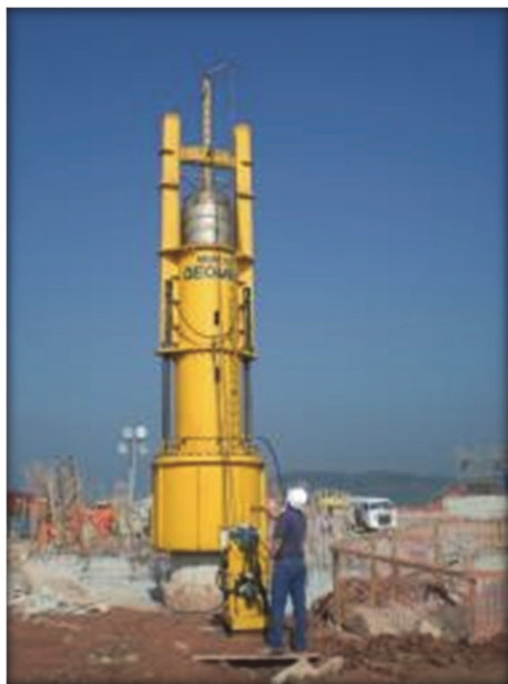
Fig. 1 – ECD – obras em terra.
