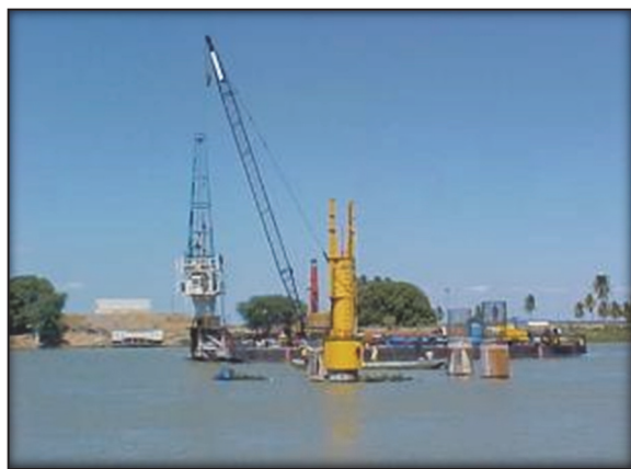
Fig. 2 – ECD – obras com lâmina de água.
