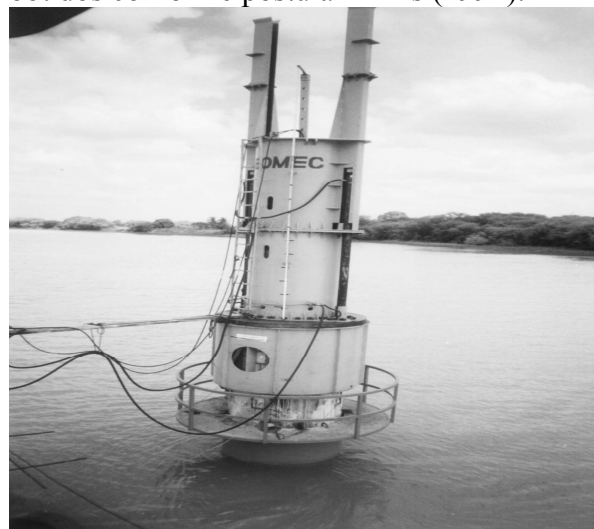
Figura 2. – ECD em estacas composite \Phi 140cm. Ponte sobre o rio São Francisco Ibó BA..
