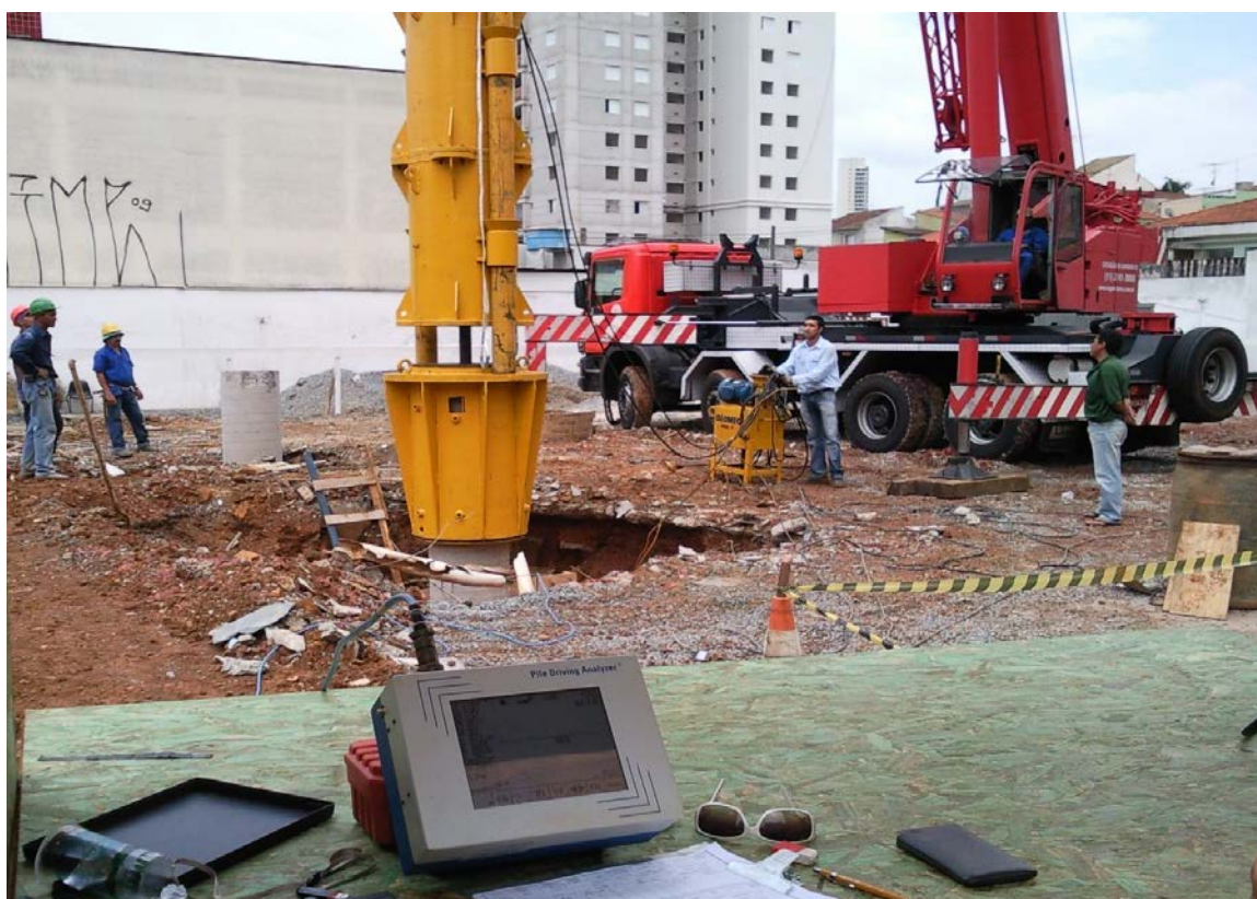
Foto 3. Vista geral do ensaio de carregamento dinâmico com destaque para o sistema de impacto hidráulico auto-modulável da GEOMECC para até 8 tf.
