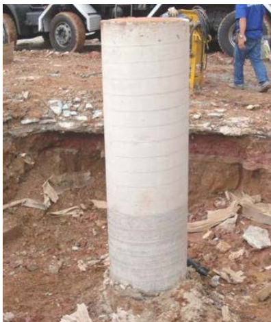
Foto 1. Bloco sobre a estaca
