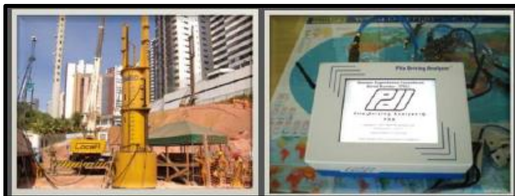
Figura 12. Martelo MHAP20 e Sistema de Aquisição de dados PDA – Modelo PAX
